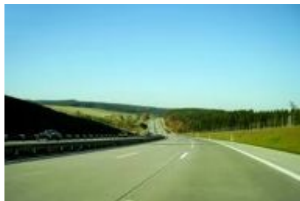
Autobahn mit einer Betondecke
