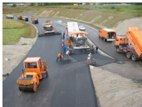
Neubau einer Strassenschicht
